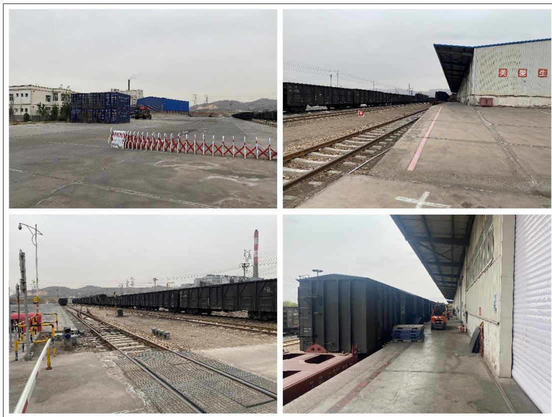
呼铁君正储运基地现场图
