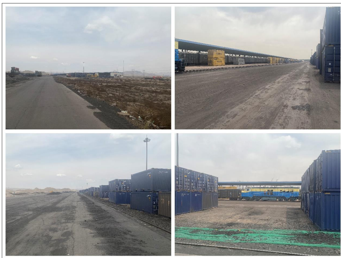
同洲物流园现场图
